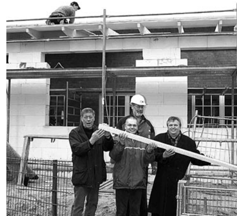
Der Sprecher der Sportdeputation, Jürgen Pohlmann (rechts), informierte sich am 20. März vor Ort bei Heinz Baumer, Ekkehard Lenz und Polier Friedrich Ulken (von links) über den Stand der Umbaumaßnahmen bei TURA.
