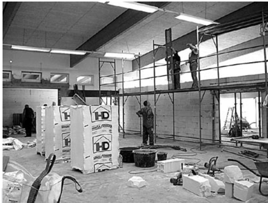
Im TURA-Vereinszentrum an der Lissaer Straße sah es in den letzten Monaten mächtig nach Baustelle aus.
